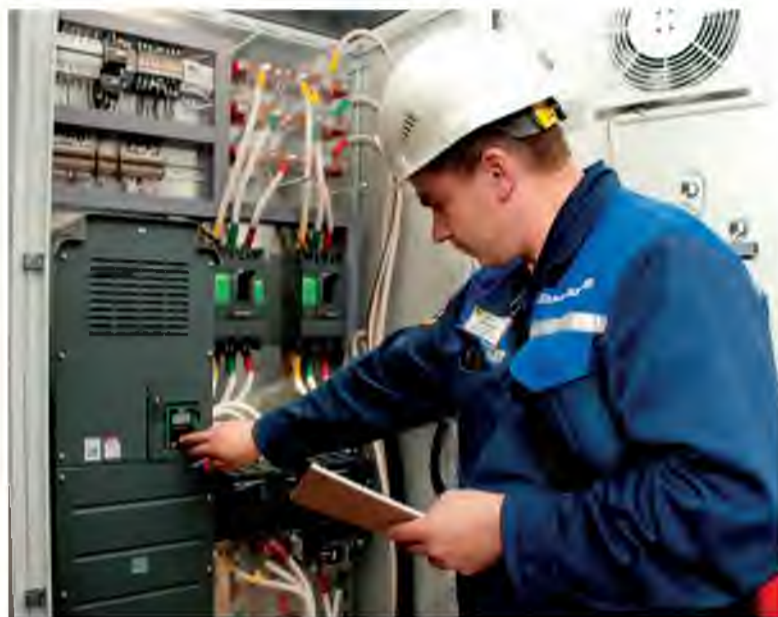
Во время капитального ремонта на агрегате №5 был установлен частотный привод для регулирования нагрузок на вентилятор градирни
